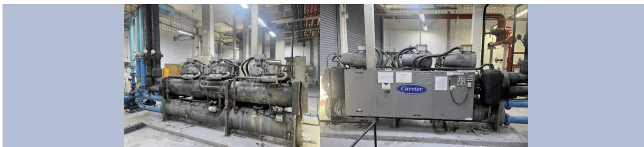
備註：更換冰水機系統
