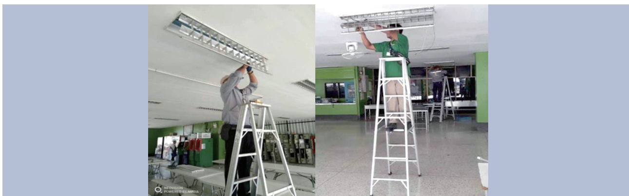
備註：於碧武里之工廠安裝LED
